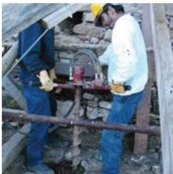
**6. Injeção de calda de cimento a alta pressão**
