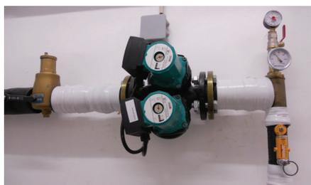
Se forem utilizados ventiladores automáticos deve ter-se em conta a temperatura máxima de operação, por forma a compatibilizar com a temperatura do circuito solar. Ventiladores que suportam temperaturas até 150oC podem ser instalados.
