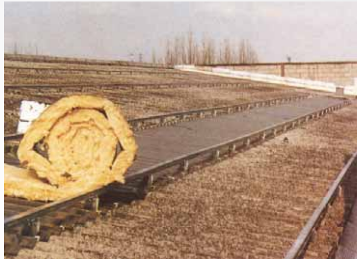
Mantas de lã de rocha (reforço do isolamento térmico)
