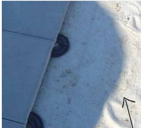
PROTEÇÃO COM LAJETAS SOBRE OS APOIOS
