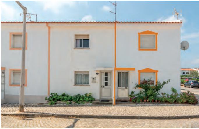
FIG. 3 Bairro de Bensafrim, Lagos, 2010 (autor não identificado para FFH, 1971-1972). Arquivo do IHRU
