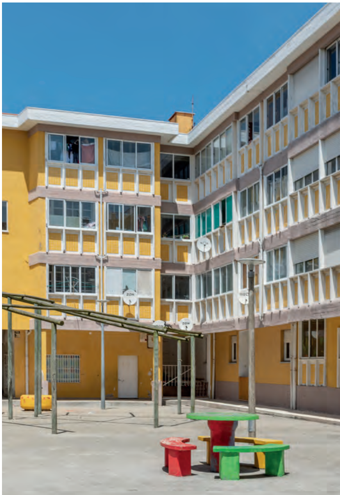
FIG. 15 Bairro do Arco-Íris ou Bairro de Peniche III, Peniche, 2010 (arquiteto Helder de Almeida para GTH de Lisboa). Arquivo do IHRU
