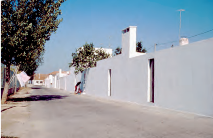
FIG. 21 Bairro para a Casa do Povo de Benavente, Benavente [c. 1970] (arquiteto Vítor Figueiredo para as HE, 1965). SIPA/VF
