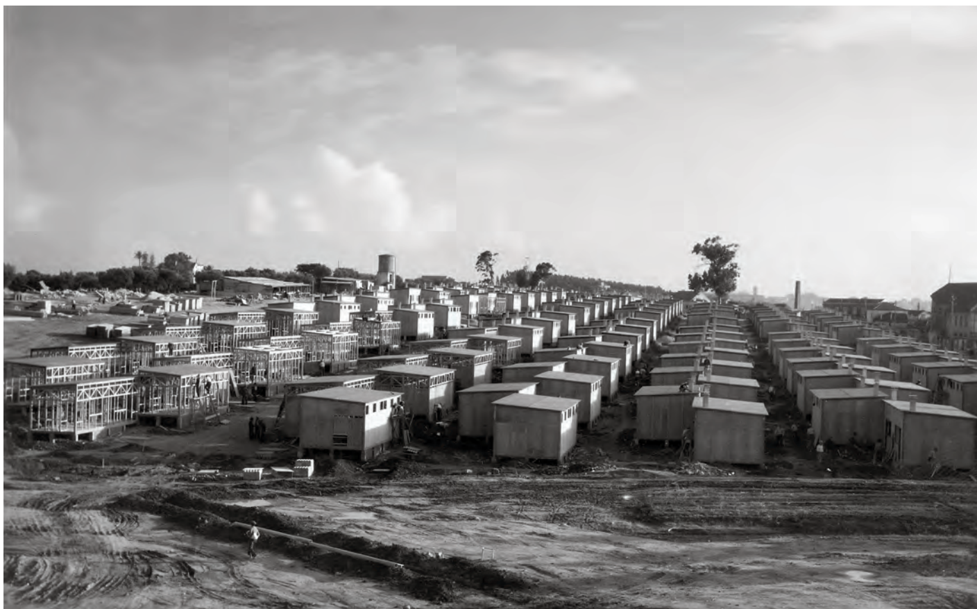
FIG. 11 Bairro de Casas Desmontáveis da Quinta da Calçada, em construção, Lisboa, 1939 (CML, 1938-1939). CML/AML
