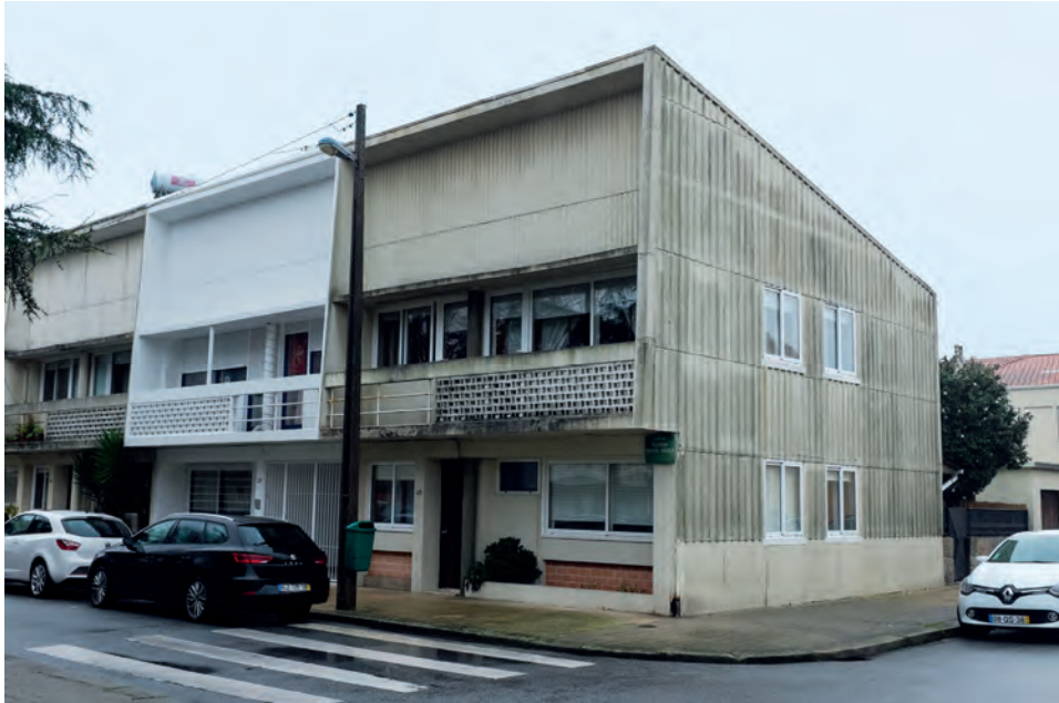
FIG. 1 Fachada da Cooperativa O Lar Familiar, Porto, 2017 (Mário Bonito, 1950-1955). João M Almeida
