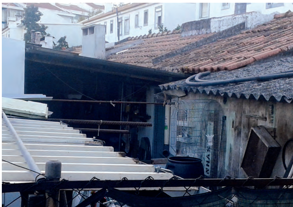
FIG. 7 Logradouro do Bairro Gulbenkian, Mealhada, Loures, 2017. CEG/IGOT/ULisboa
