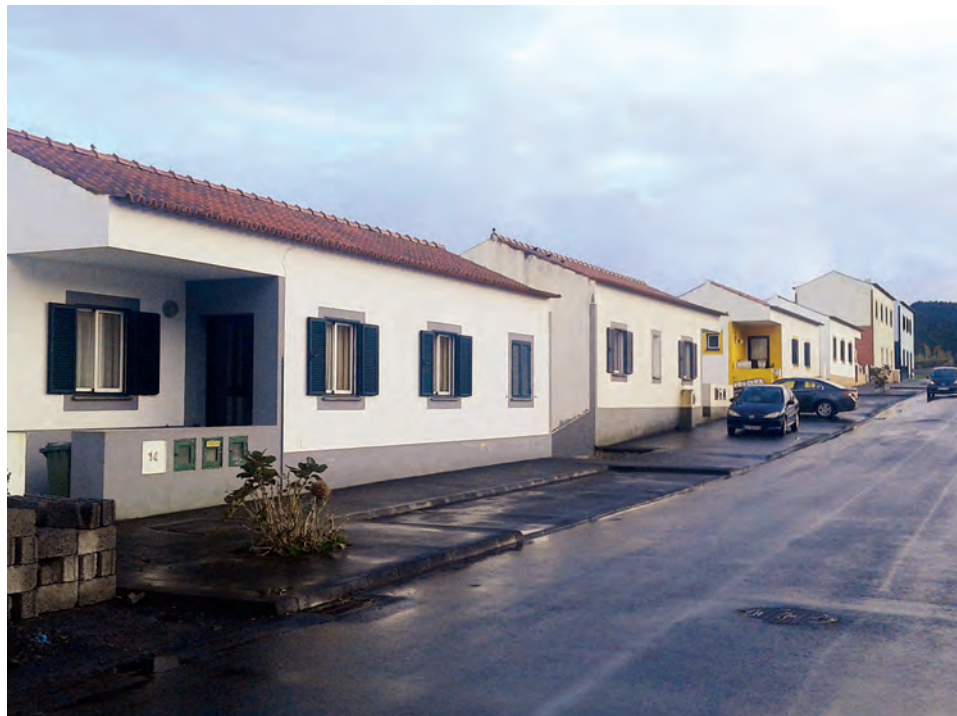
FIG. 19 Casas construídas na sequência do sismo de 1998 (freguesia de Pedro Miguel, Faial), Faial, 2018. CEG/IGOT-ULisboa
