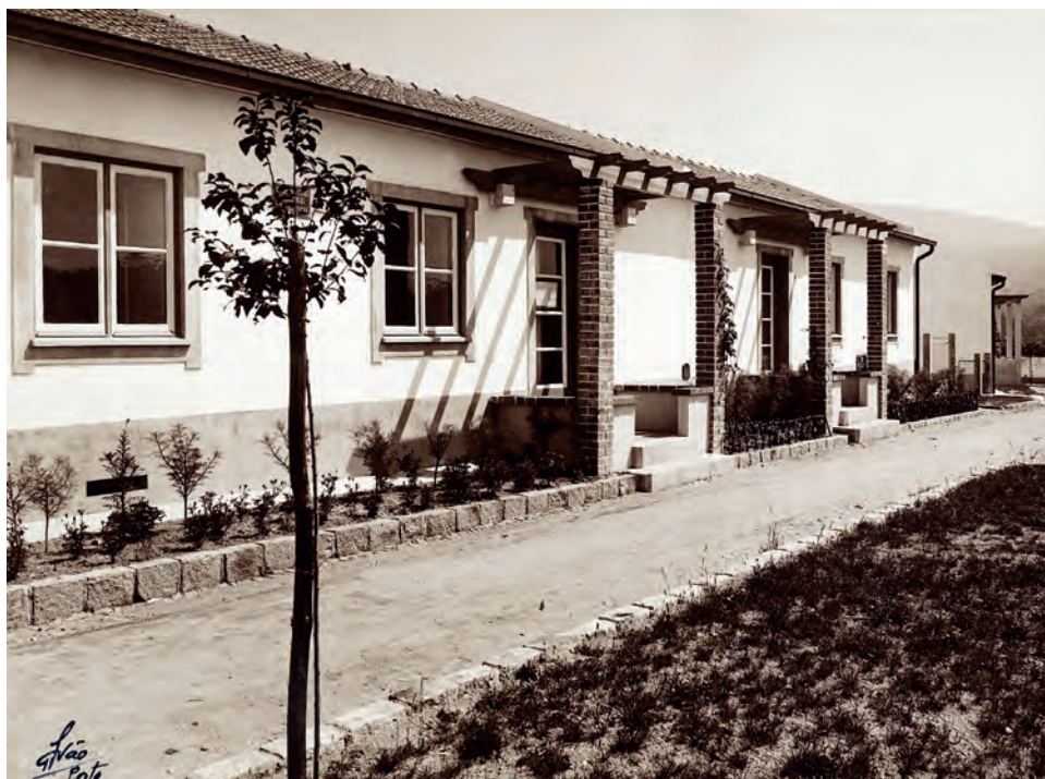
FIG. 7 Bairro de Casas Económicas Duarte Pacheco, Braga (arquiteto Joaquim Madureira para a DGEMN, 1935-1939). SIPA/DGEMN
