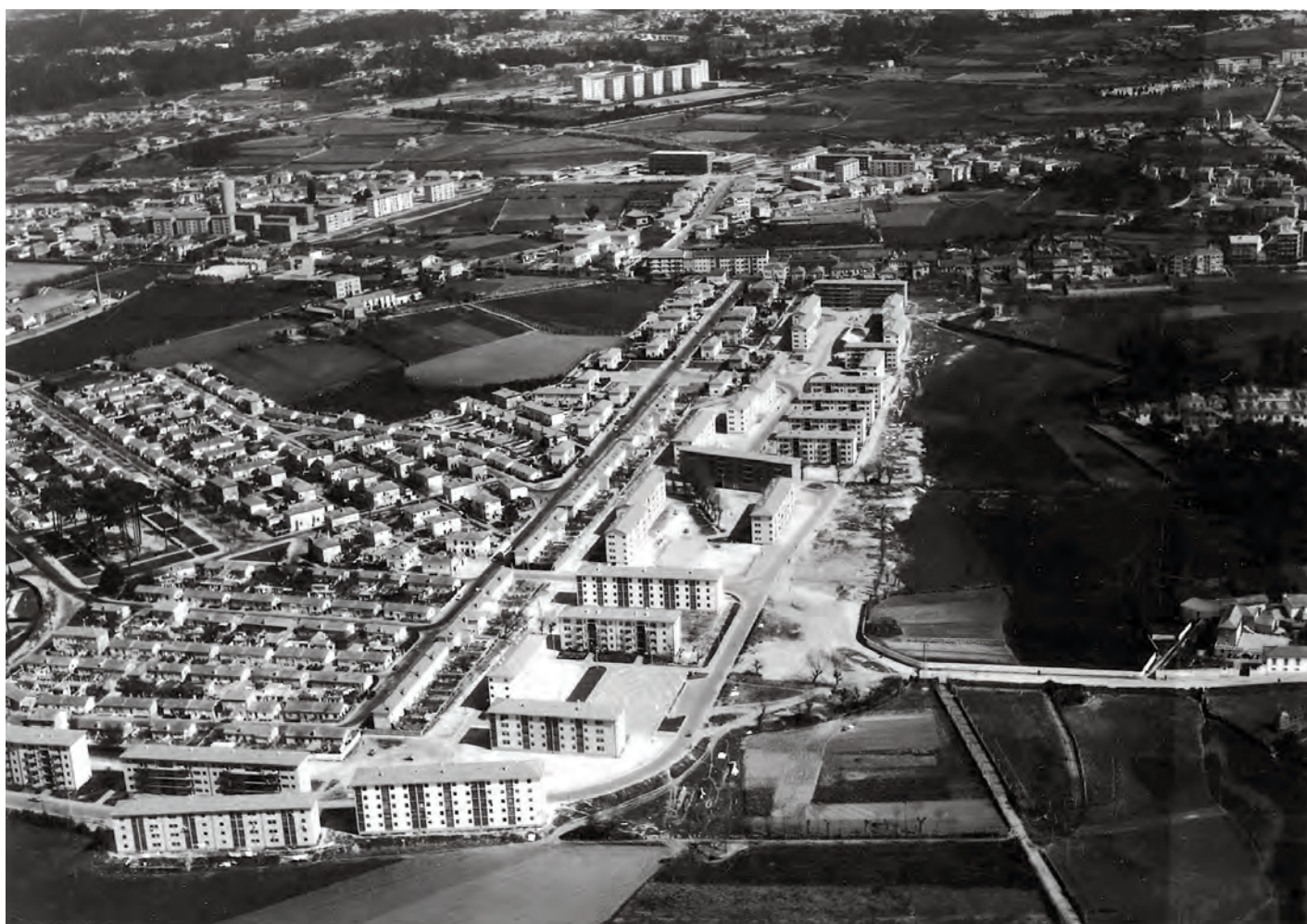
FIG. 5 Vista aérea do Bairro de Casas Económicas do Amial e do Bairro de Moradias Populares do Regado, Porto [c. 1966] (Bairro do Amial: 1.ª fase — arquiteto Joaquim Madureira para a DGEMN, 1938; 2.ª fase — DGEMN, 1957). CMP/AHMP
