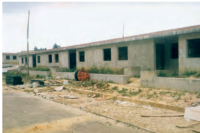
FIG. 10 Tipologia de bairro CAR em construção [c. 1977]. Arquivo do IHRU
