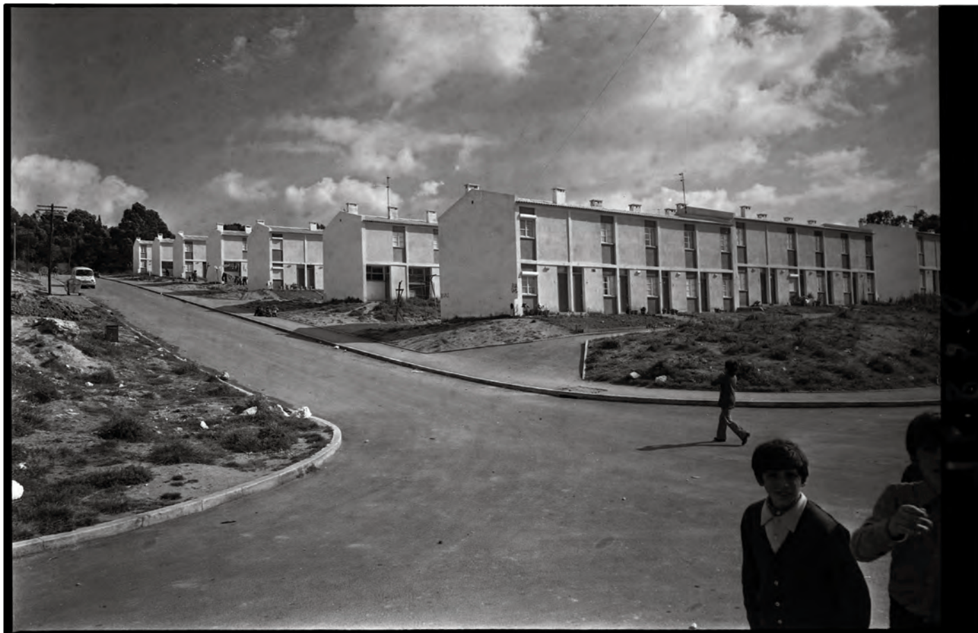
FIG. 14 «Bairro da Boavista», Lisboa, 1975. CML/AML. Armando Maia Seródio. Os primeiros 488 fogos do Bairro da Boavista foram construídos pelo município de Lisboa no âmbito do Programa de Casas Desmontáveis (1938) e concluídos em 1944, no limite norte do Parque Florestal de Monsanto. As bandas de casas retratadas na imagem — conjunto chamado «Bairro Novo da Boavista» — foram erguidas na quarta fase do bairro (1971-1975), e encontravam-se ainda por atribuir ou em fase de conclusão quando, na sequência do 25 de Abril de 1974, foram ocupadas por famílias carenciadas.
